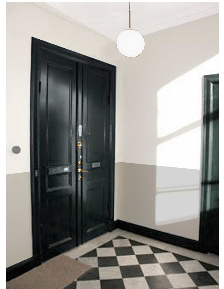
Ytor kompletteras med nytt marmorgolv lika befintligt schackrutigt mönster
